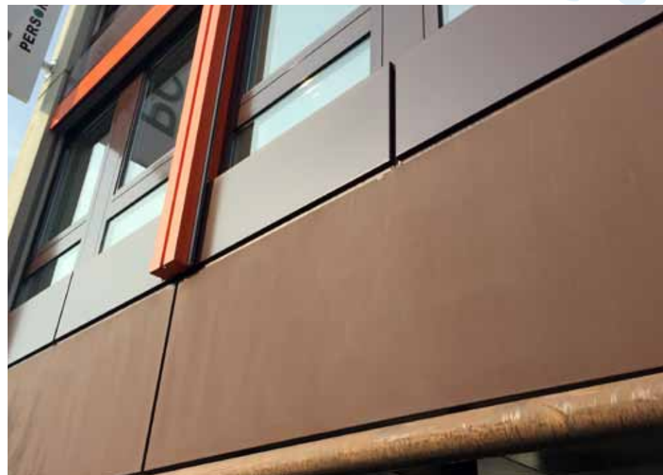
Unterer Teil vor und oberer Teil nach der Versiegelung.
